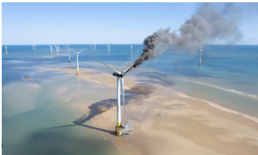
Рис. 7.3-7.4. Пожежа на вітроагрегатах
