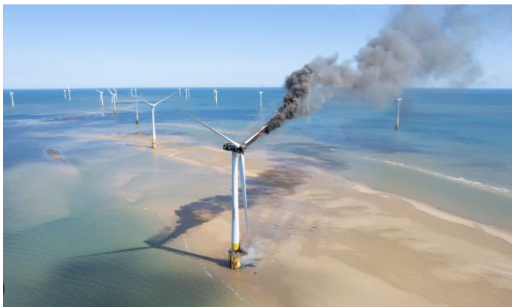
Рис. 7.3-7.4. Пожежа на вітроагрегатах
